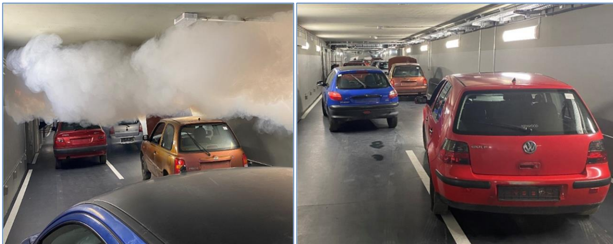
Abb. 6: Blick in die neuerbaute Tunnelübungsanlage 1
