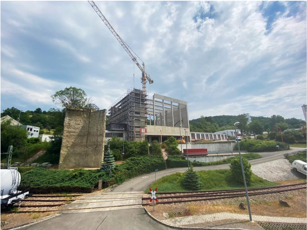
Abb. 6 Neubau der Übungshalle an der TLFKS 1
