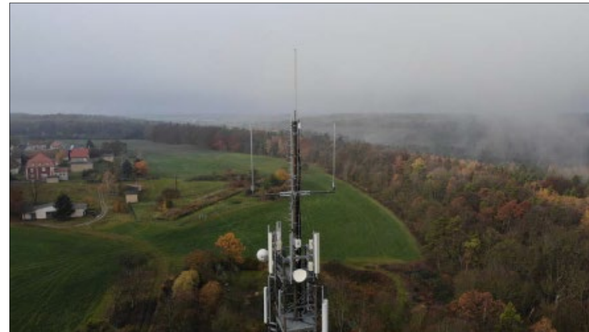
Antennenanlage einer Digitalfunk TETRA-Basisstation.
