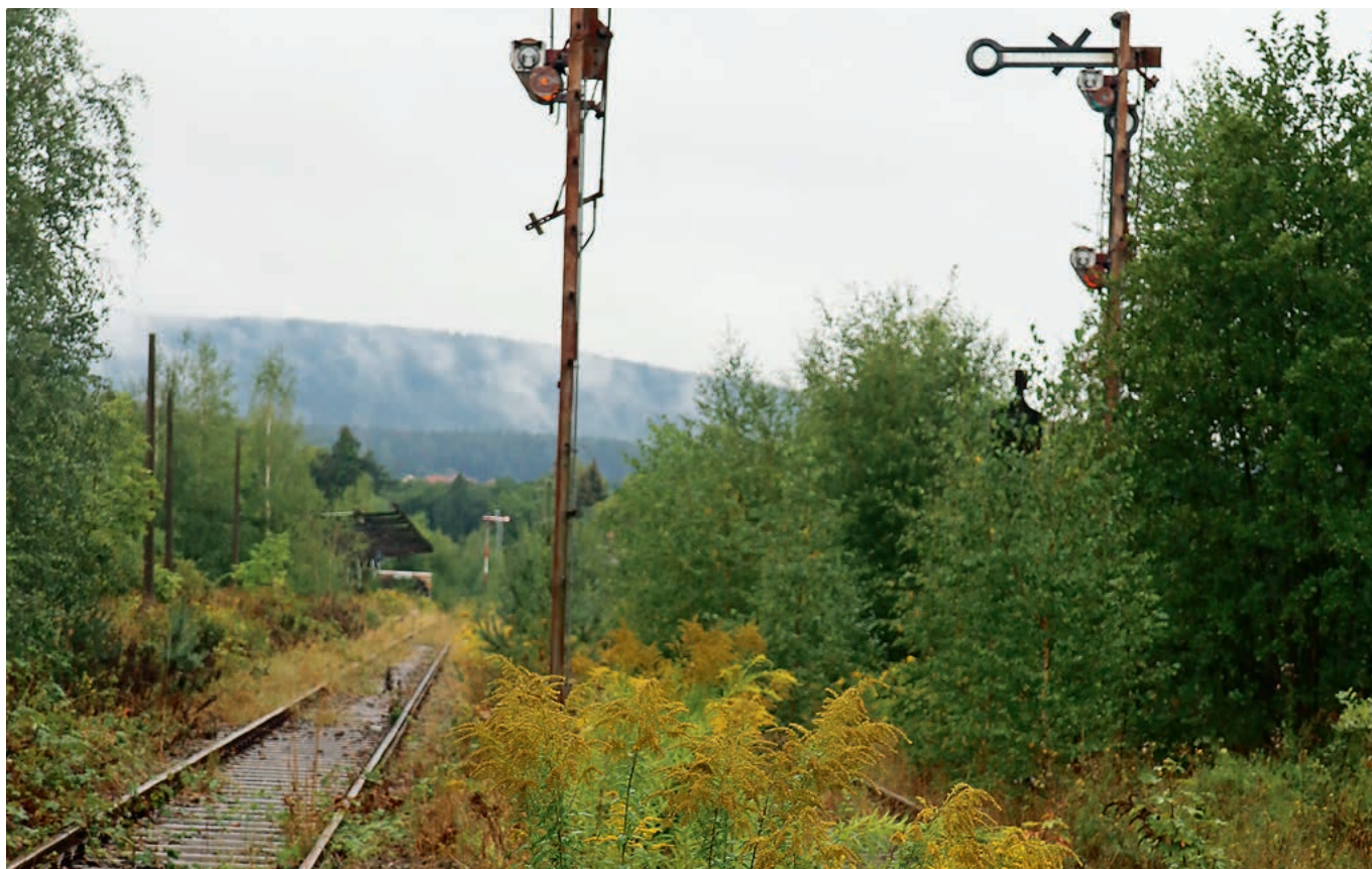
Teile der Signalanlage der Ohratalbahn am Bahnhof von Georgenthal
