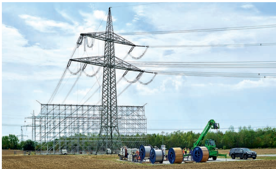
Vorhaben Nr. 13 Pulgar-Vieselbach, Seilzug im Abschnitt Ost zwischen Pulgar und Geußnitz
