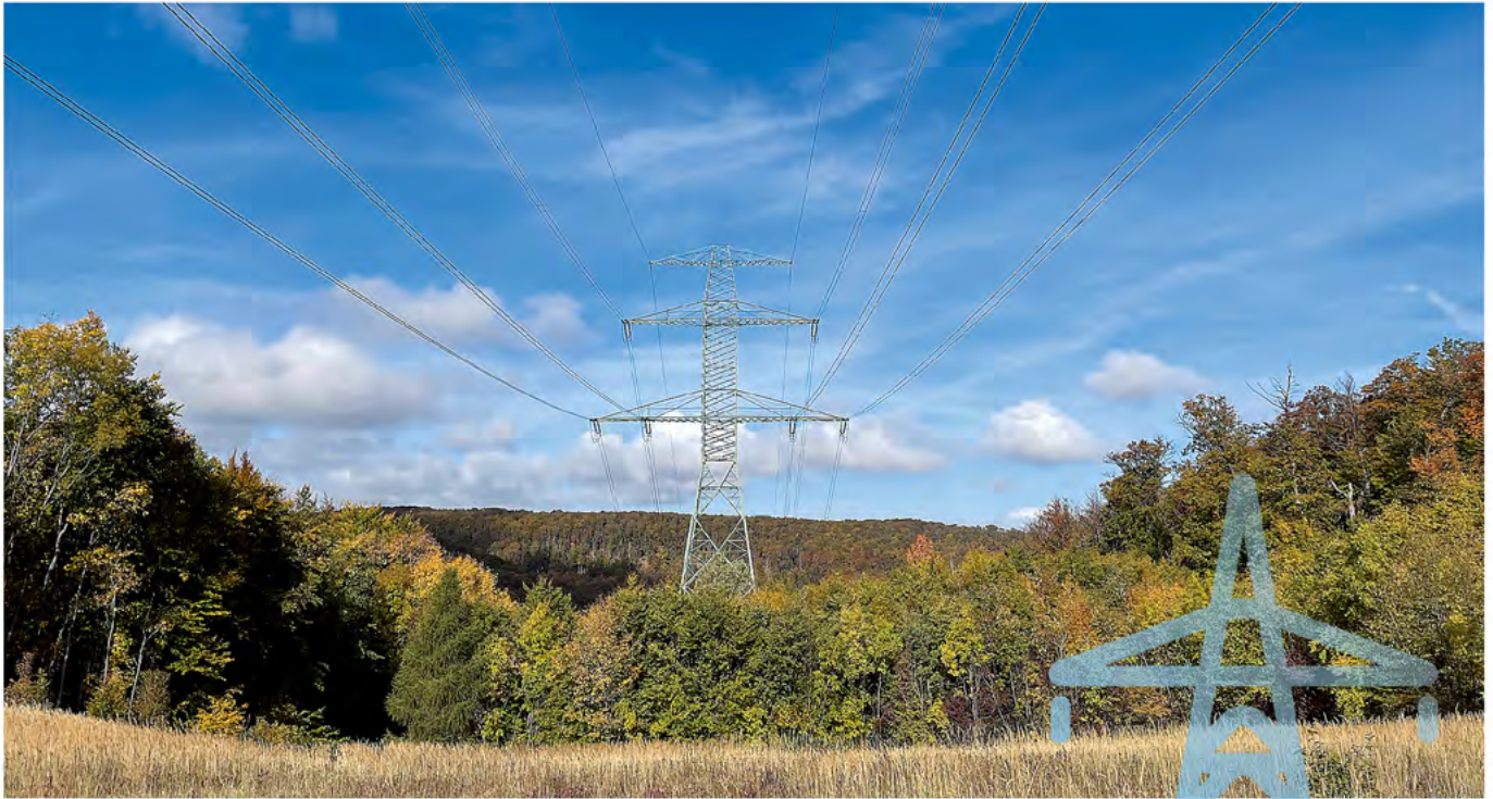
220-kV-Leitung Vieselbach-Wolkramshausen in der Hainleite in der Nähe von Wernrode
