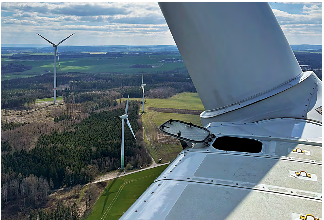
Windenergieanlage im Wald bei Auma
